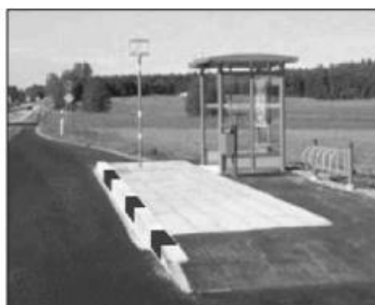
Рисунок 2.19.5 – Пример обустройства остановочного пункта пандусом
